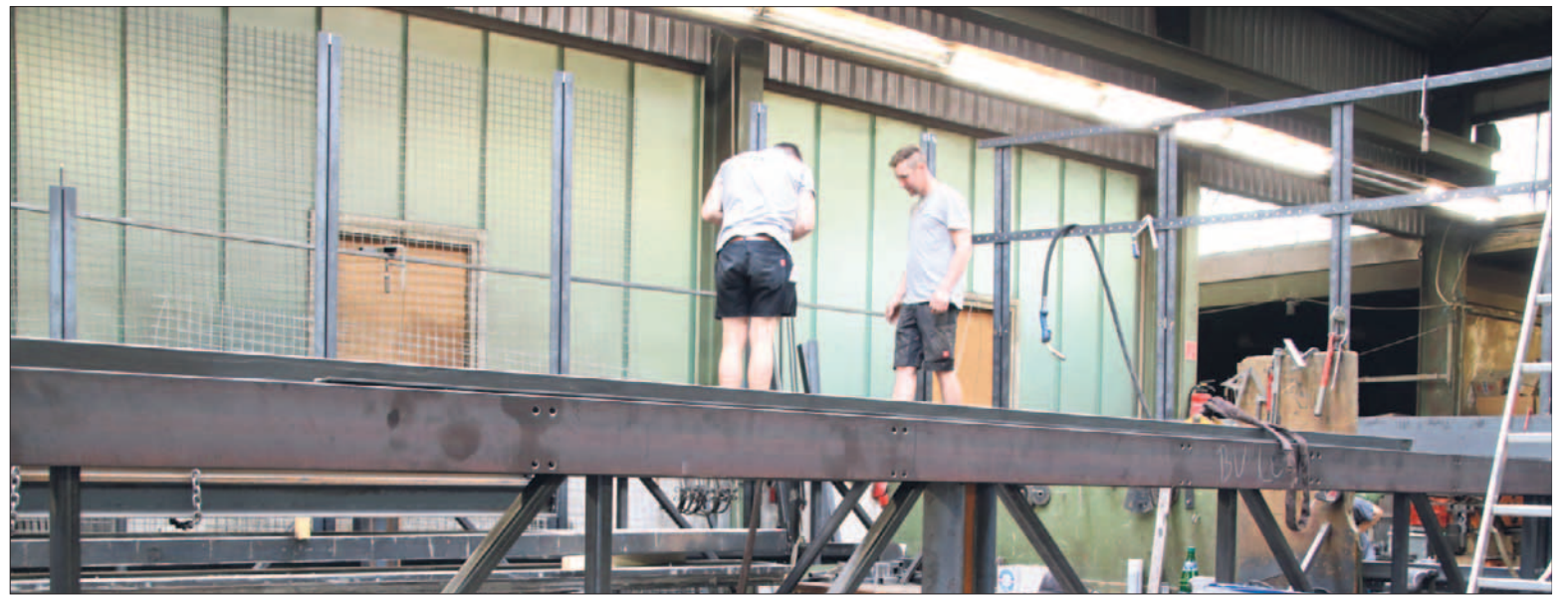
Stahlbau ist die Kompetenz von Ruhland.
